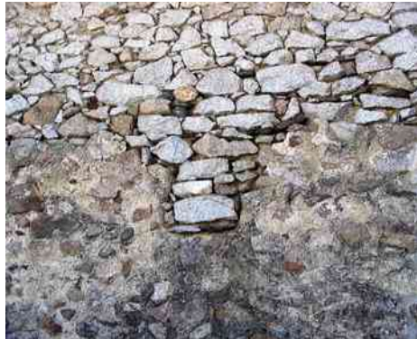
Photo n°3 Remaniement des murs
